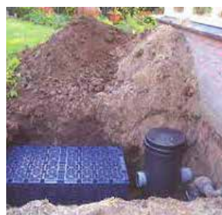
Klimaatadaptieve inrichting van de tuin door middel van regenton, wadi, infiltratiekratten en minimaliseren verharding
