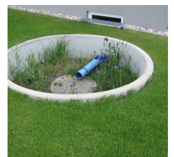
Klimaatadaptieve inrichting van de tuin door middel van regenton, wadi, infiltratiekratten en minimaliseren verharding
